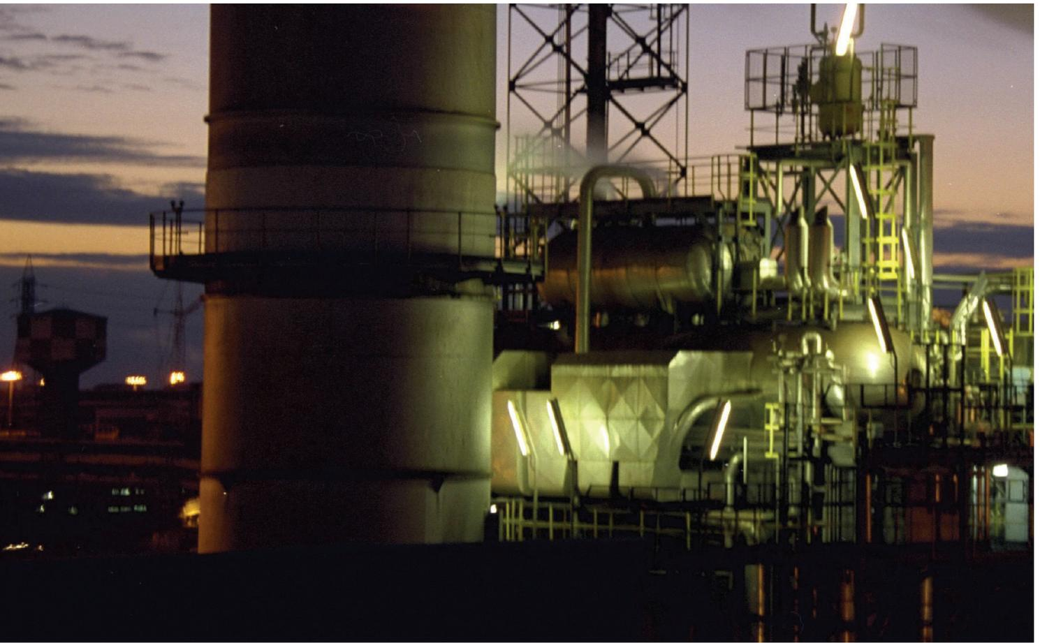
Sia per CET2 che per CET3 l'acqua demineralizzata di reintegro dei generatori di vapore proviene dalla rete dello stabilimento siderurgico. Per la condensazione del vapore e per il raffreddamento degli impianti ausiliari viene utilizzata acqua di mare, fornita dallo stabilimento siderurgico, che proviene dal Mar Piccolo di Taranto. L'acqua di mare in uscita dai condensatori/scambiatori viene restituita allo stabilimento Acciaierie d'Italia per successivi usi di processo.
